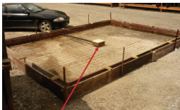
Drain pour l'écoulement des eaux de ruissellement
