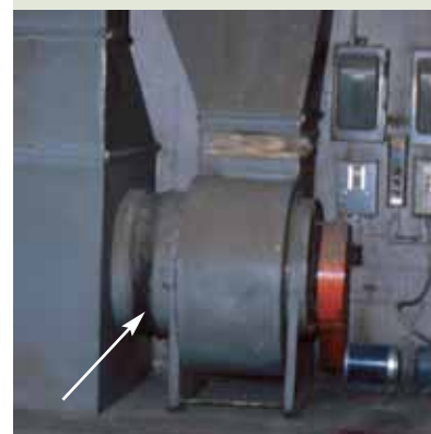
Le soufflet empêche le bruit du moteur d'être transmis par les conduits de ventilation.
