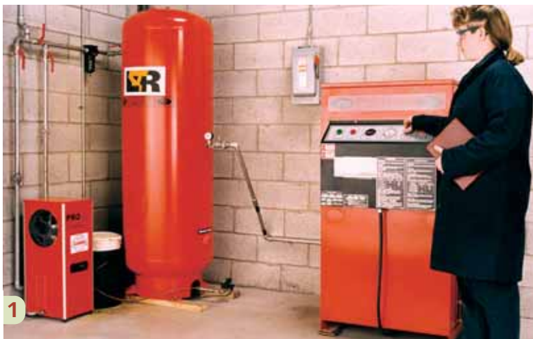
1 Les compresseurs rotatifs sont compacts et fonctionnent sans pulsation ni vibration, même à de grandes vitesses.
