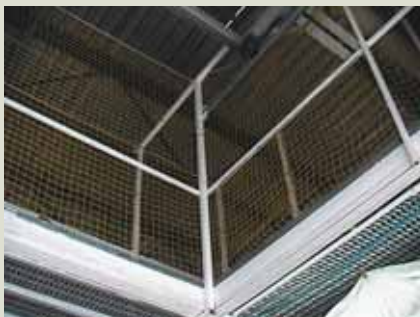
La mezzanine d'entreposage est une structure dont la solidité a été étudiée et qui permet d'entreposer jusqu'à 1 600 pneus.
