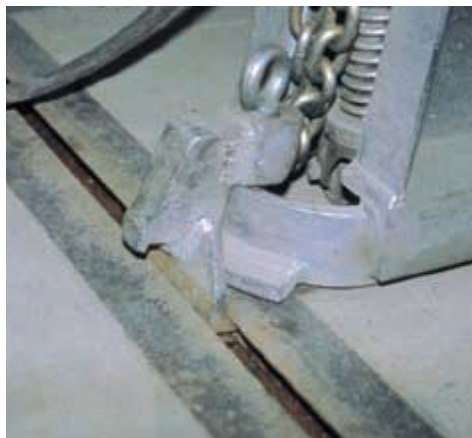
Pied d'une tour de traction ancré dans un rail.
